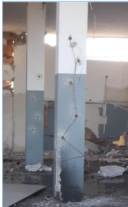
Figura 4.3 - Detaje nga procesi i demolimit të strukturave (foto të marra nga xhenierët e Ministrisë së Mbrojtjes)
