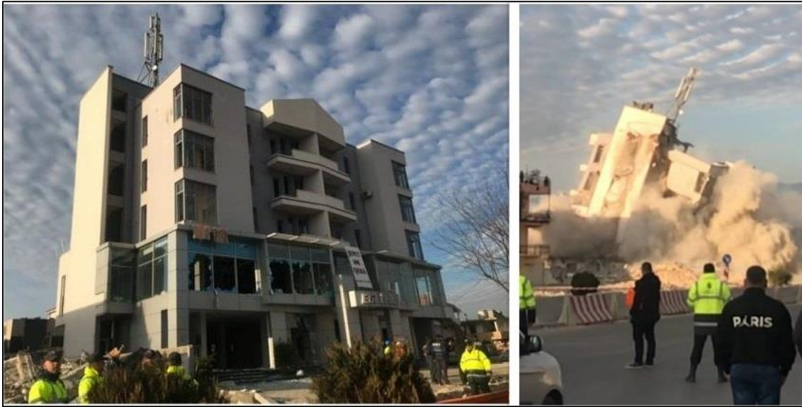
Figura 1.12- Shembja e godinës 5 kate, konstruksion b/a, Tiranë, 2020 (foto autori)
